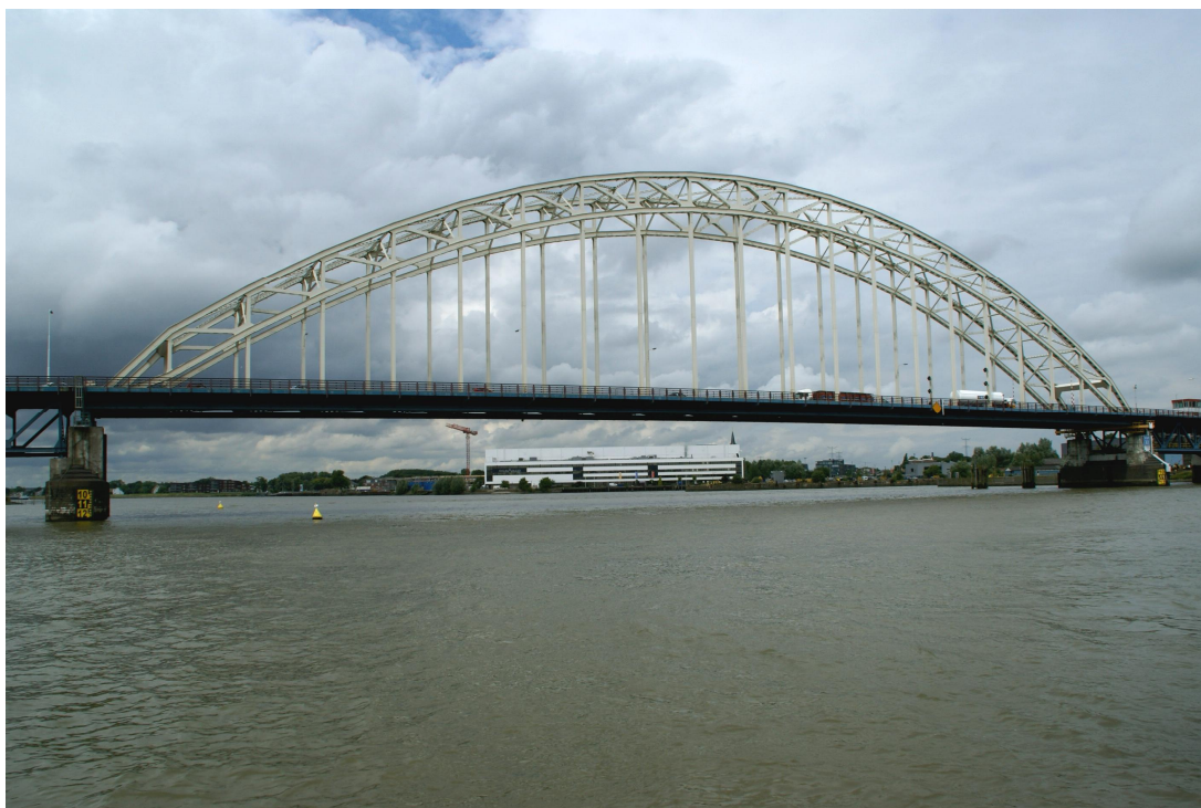
Figuur 2-17: Alblasserdamsebrug [BRON: HKV].
