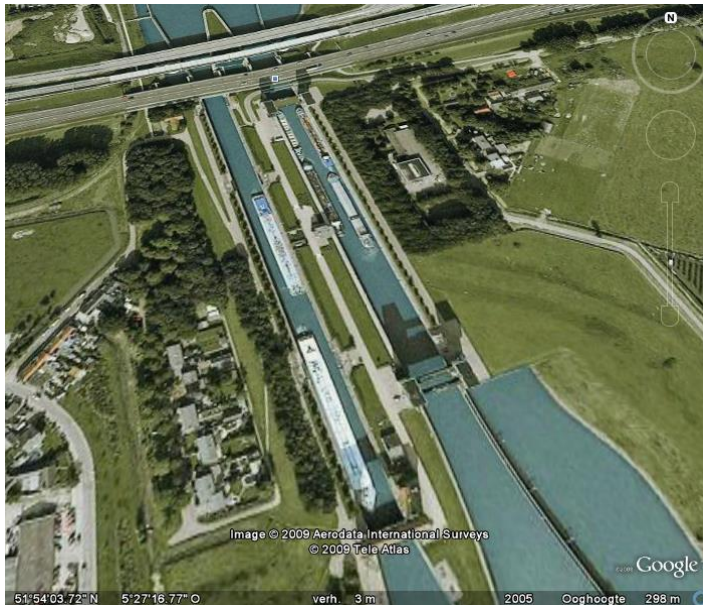
Schutsluiscomplex Tiel (Prins Bernhardsluis)
