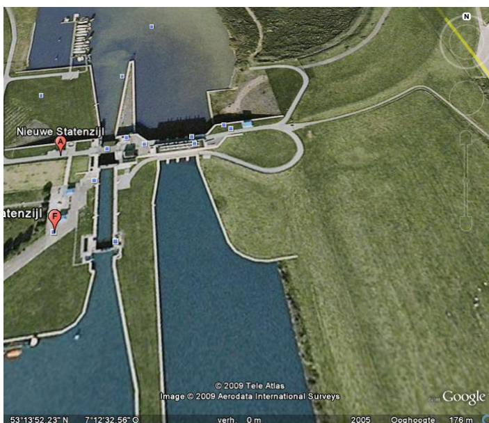
Spuisluis Nieuwe Statenzijl
