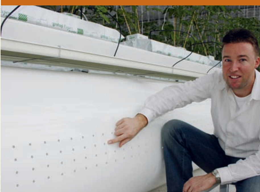
Ferdinand van Elswijk: "De uitblaasopeningen in de onder de teeltgoten hangende folieslangen zitten horizontaal, zodat de lucht gelijkmatig over de kas wordt verdeeld zonder dat de planten teveel 'wapperen'."
