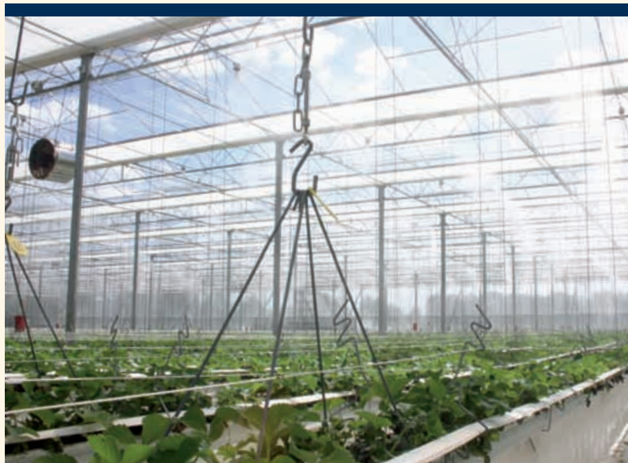
Om op warme dagen de luchtvochtigheid op peil te houden, heeft Guido Herrijgers een hoge druk vernevelingsinstallatie tot z'n beschikking.
