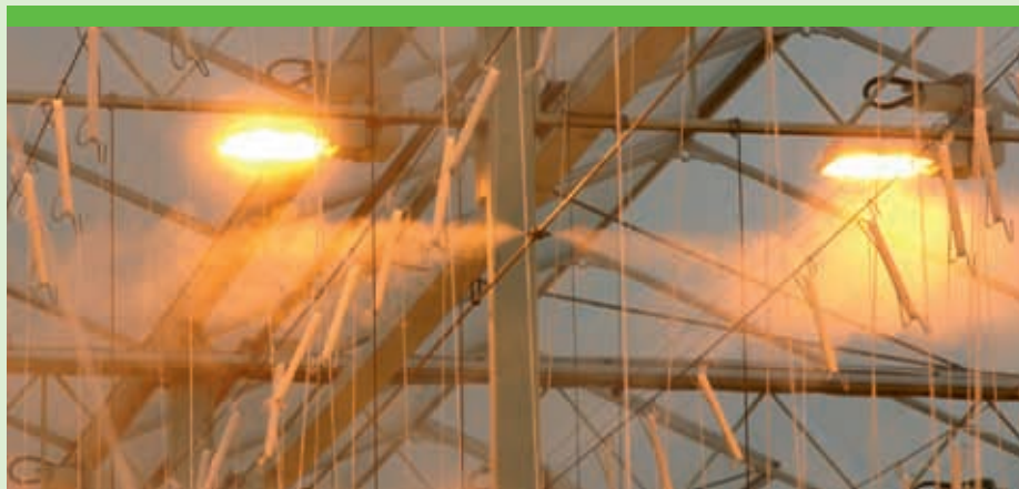
Prominent kan met een hogedruknevelleiding 400 cc water/m 2 verdampen. Dat zorgt voor 250 W/m 2 koeling.
