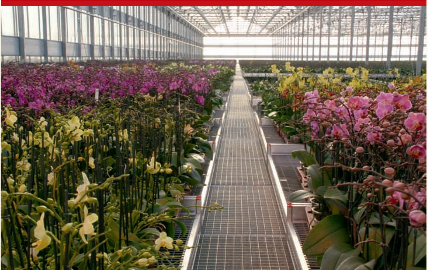
Bij van der Hoorn liggen de looppaden op dezelfde hoogte als de containers. Onder de looppaden ligt het koude-/warmte-afgiftesysteem in de lengte van de kas met om de twee meter een ventilator, die de lucht door het warme of koude blok trekt en onder de tafels blaast.
