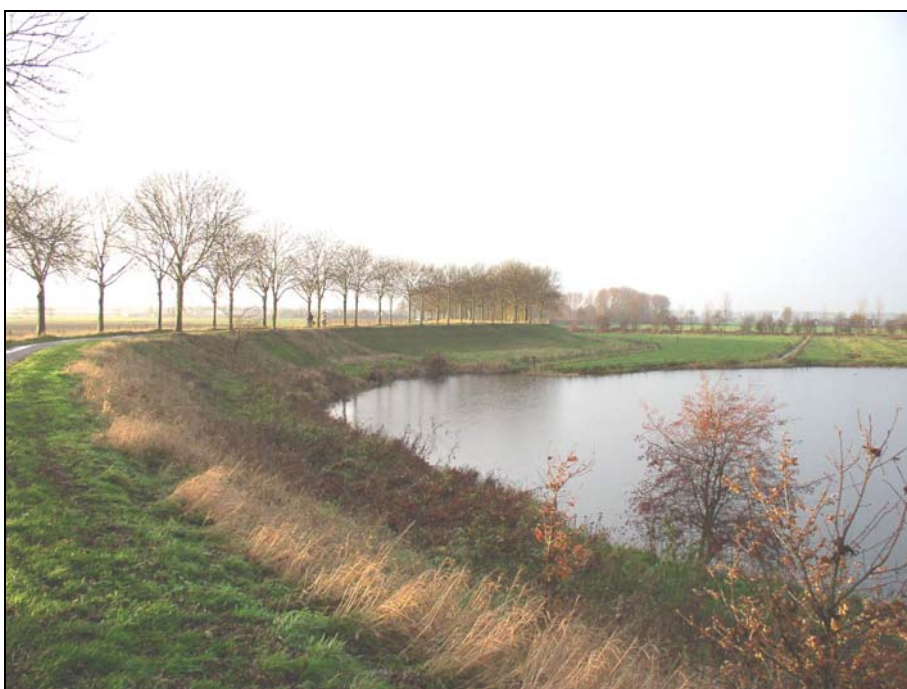
Wiel (doorbraakkolk) langs de Zeedijk tussen Doeveren en Elshout. Foto Dolf Bekius
