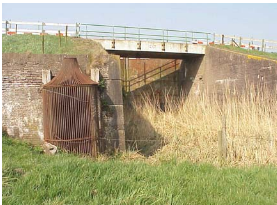
Inlaatsluis met verdedigingsgangen in de dijk tussen het Werk aan de Bakkerskil en het dorpje Kille
