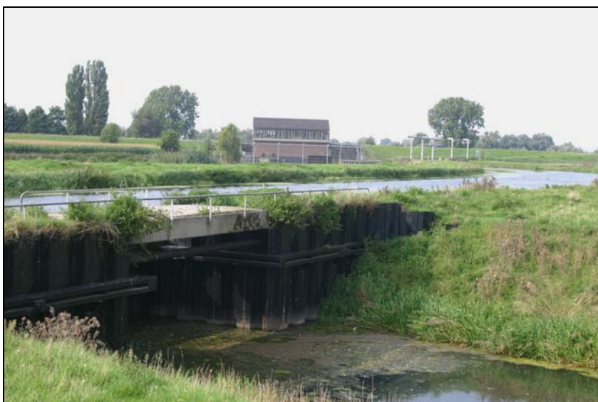
Gemaal Gewande en de Hertogswetering. Op de voorgrond de veel lager gelegen Roode Wetering, waarvan het water met een sifon onder de Hertogswetering door wordt geleid.
