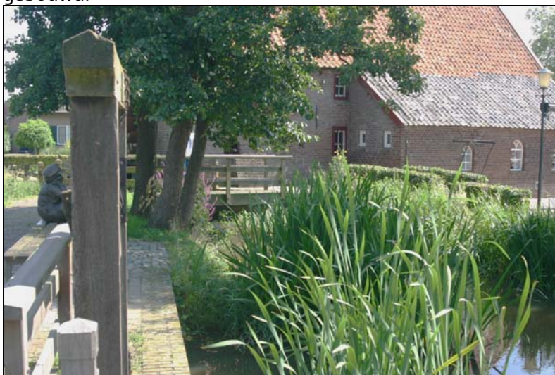
De sluis en het molengebouw van de watermolen in Oploo.
