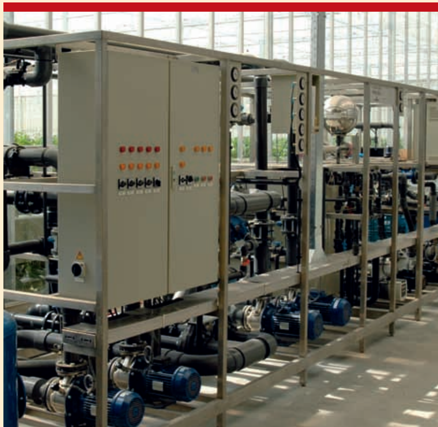
De Vialux hogedruk UV-ontsmetter is volledig te automatiseren met de Intégro procescomputer (foto: Priva BV).
