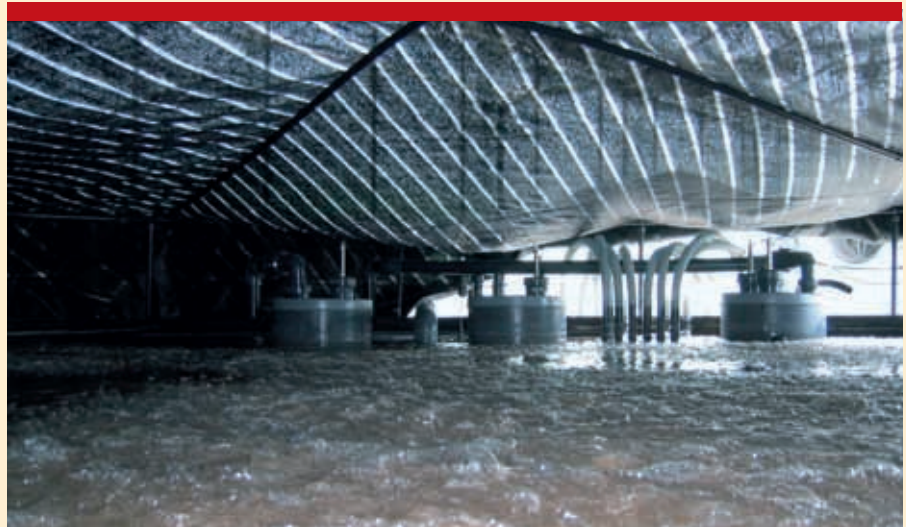
De langzame zandfiltratie is een niet-chemische en relatief goedkope manier om water te ontsmetten (foto Van Etten Techniek BV).
