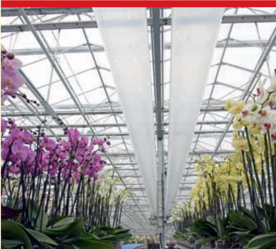
Op kwekerij Orchios hangen de luchtverdelingslangen boven en onder in de kas voor een optimale verdeling.
