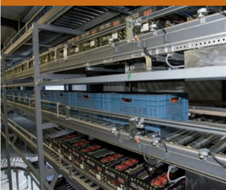
In de buffer met vier etages passen in totaal acht verschillende sorteringen.
