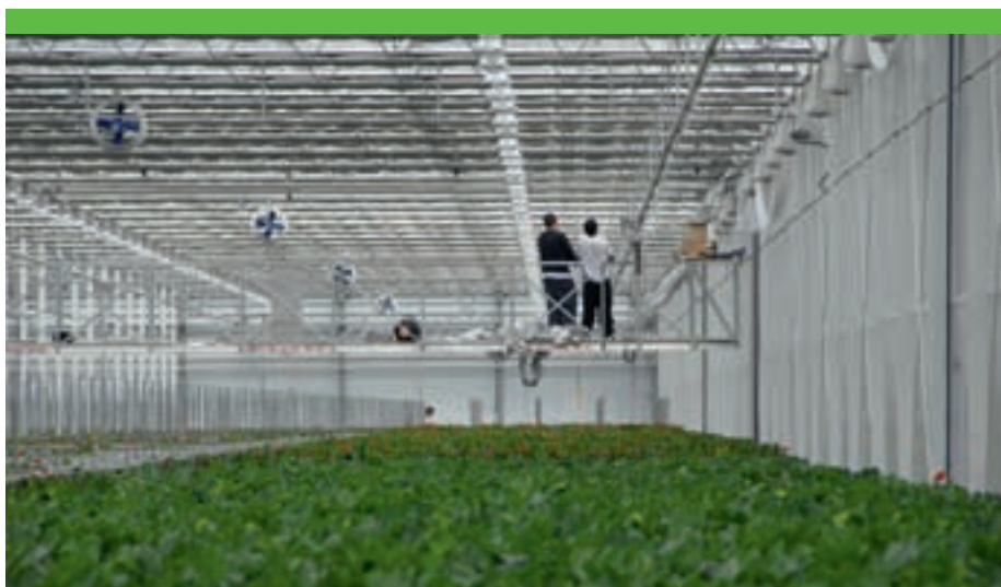
De kappen staan gedraaid ten opzichte van de bedrijfsruimte zodat de tafels niet hoeven te draaien bij de overgang van kas naar bedrijfsruimte.
