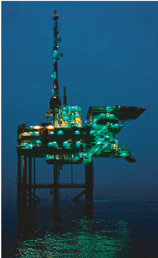
Fig. 3. Groen licht toegepast op boorplatform L15-FA-1. Alleen het helikopterdek is verlicht met wit licht. Foto: NAM
