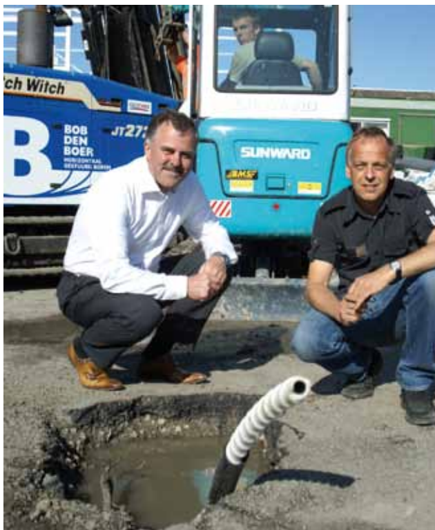
◀ Samen willen Roon Hylkema (l) en Rijkman Lehmann met hun bedrijf Geothex het gebruik van aardwarmte de doorbraak bezorgen. Op de voorgrond een al geplaatste warmtewisselaar.
