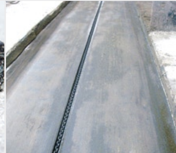
Gietasfalt toplaag met ruimte voor ketting van de mestschuif.
