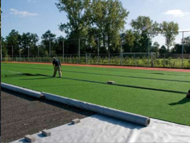
8. Er moet iemand op zijn knieën blijven zitten om verschuiven tegen te gaan wanneer een collega de mat wat op en neer wappert om hem goed strak en recht te leggen.
