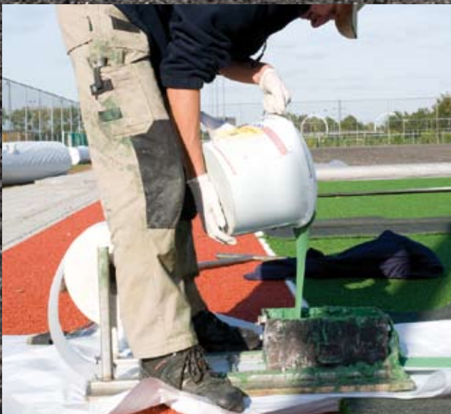
10. Lijm in de 'kitbak'. Deze bak is een lijmverdeler.
