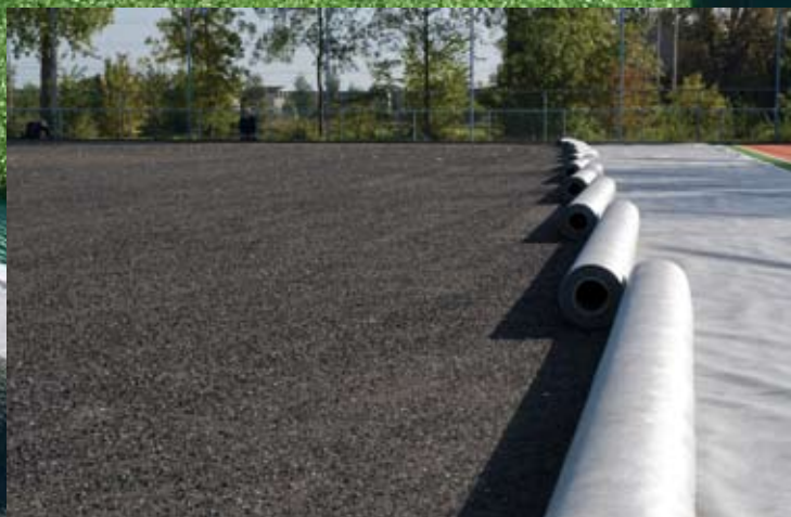
1. Rollen Geotextiel: dit soort doek verdeelt de druk over het veld en vormt een beschermende laag tussen onderbouw en kunstgras.
