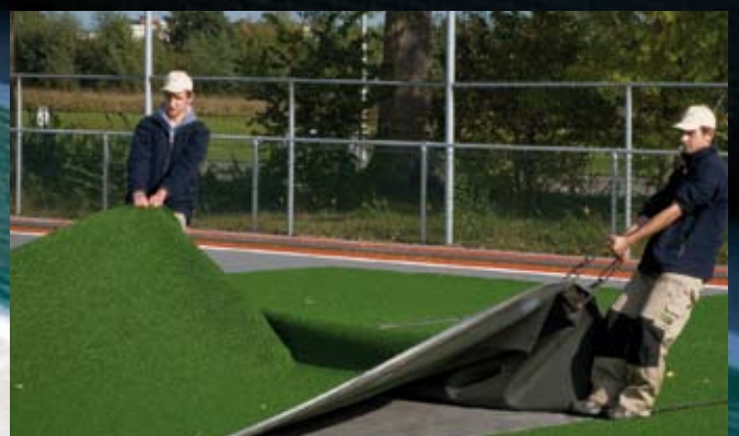
7. Nog eens strakker trekken van de mat.
