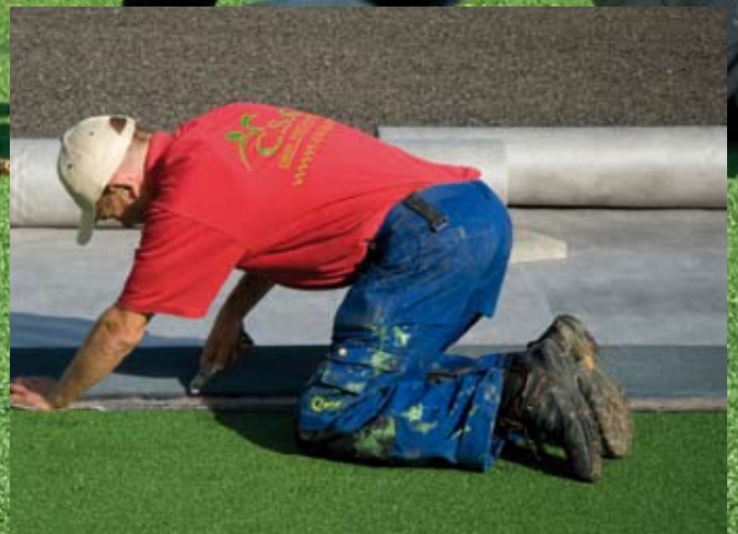
5. Randjes afsnijden. Deze randen zijn een teveel aan materiaal, die gebruikt kunnen worden om de lappen aan elkaar te kunnen naaien. Dit gebeurt veel in de Verenigde Staten. In Nederland worden velden bijna altijd gelijmd.
