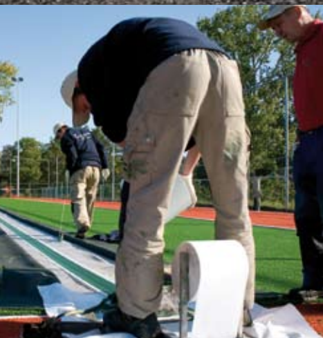
13. Nauwkeurig wordt nagelopen of de matten goed tegen elkaar aan liggen. Hierbij moet je oppassen dat er geen lijmplekken op de mat terechtkomen: als de lijm ergens onverhoopt ergens te dik is opgebracht en nog niet is gedroogd, komt hij wel eens wat onder de naden uit wanneer je over het veld loopt. Die kan aan je schoenen gaan kleven en zich uitsmeren over de vezels.
