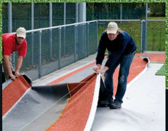
6. Met behulp van een draad wordt gekeken of de 23-meterlijn in de mat precies recht ligt.
