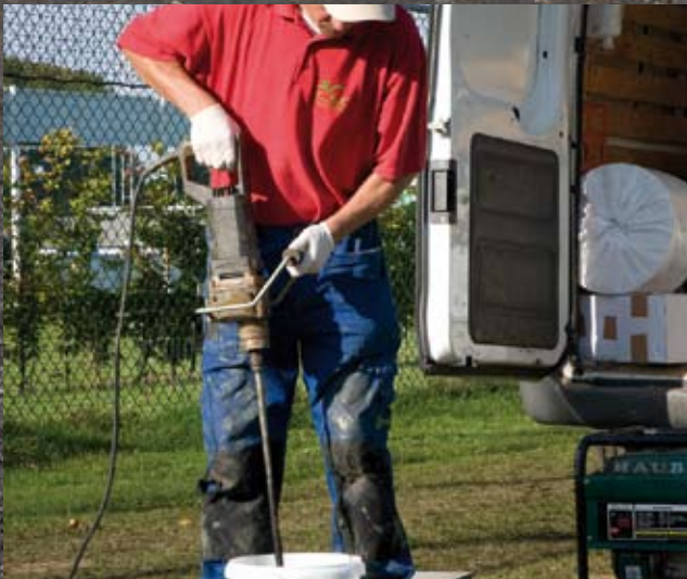
9. Mengen van de lijm. Dit betreft tweecomponentenlijm, die je moet mengen vlak voordat je gaat werken, want het droogt binnen een paar minuten.
