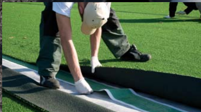
13. Nauwkeurig wordt nagelopen of de matten goed tegen elkaar aan liggen. Hierbij moet je oppassen dat er geen lijmplekken op de mat terechtkomen: als de lijm ergens onverhoopt ergens te dik is opgebracht en nog niet is gedroogd, komt hij wel eens wat onder de naden uit wanneer je over het veld loopt. Die kan aan je schoenen gaan kleven en zich uitsmeren over de vezels.
