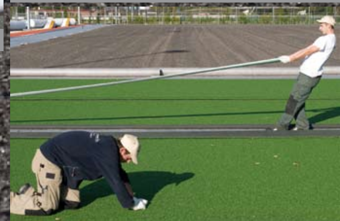
14. Nauwkeurig wordt nagelopen of de matten goed tegen elkaar aan liggen
