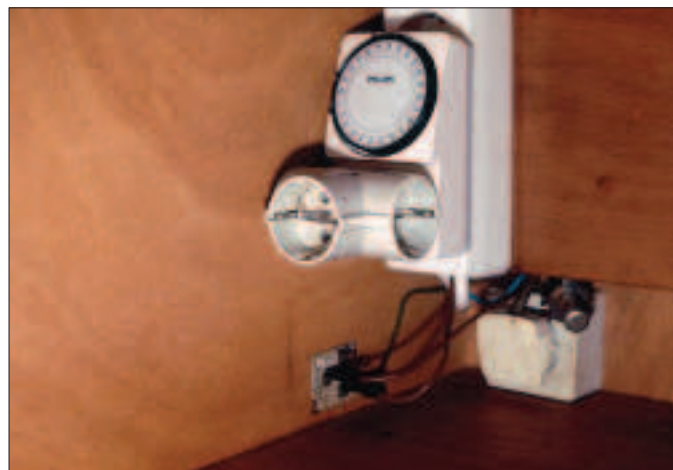
V.I.n.r. voeler van de staafthermometer – voeler thermostaat – wandcontactdoos voor kachel en grote wandcontactdoos met tijdsklok
