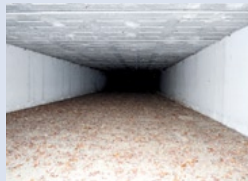
▲ Een goede luchtcirculatie is van groot belang. Controleer daarom altijd de luchtgangen en roostervloeren of deze goed schoon zijn. Door jaarlijks de gangen schoon te maken, kan de lucht probleemloos en vrij bewegen. Bovendien valt dan de hoeveelheid werk ook nog wel mee. En waar het schoon is, is het prettig werken.
