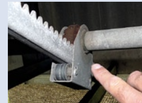
▲ De tandheugels dienen soepel te kunnen bewegen en daarmee de kleppen goed te openen en te sluiten. Controleer de bevestigingen, scharnieren en afsluiting in open en gesloten stand. De lagers kun je lichtjes smeren. De tandwielkast en aandrijfmotor behoeven normaal gesproken geen onderhoud en worden meegenomen in het periodiek onderhoud door de leverancier.
