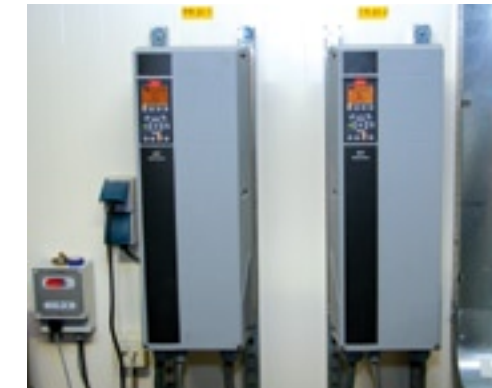
▲ Een frequentieregelaar kan tijdens het drogen de ventilatiecapaciteit verminderen.
