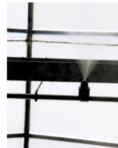
Een paar seconden is er een nevelmist te zien als er onder hoge druk water wordt verneveld in de geiten- en nertsenstallen van Van Voorthuijsen.
