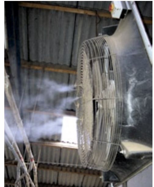
Bij Van der Veen ‘blaast’ een ventilator kleine waterdruppeltjes de stal in.
