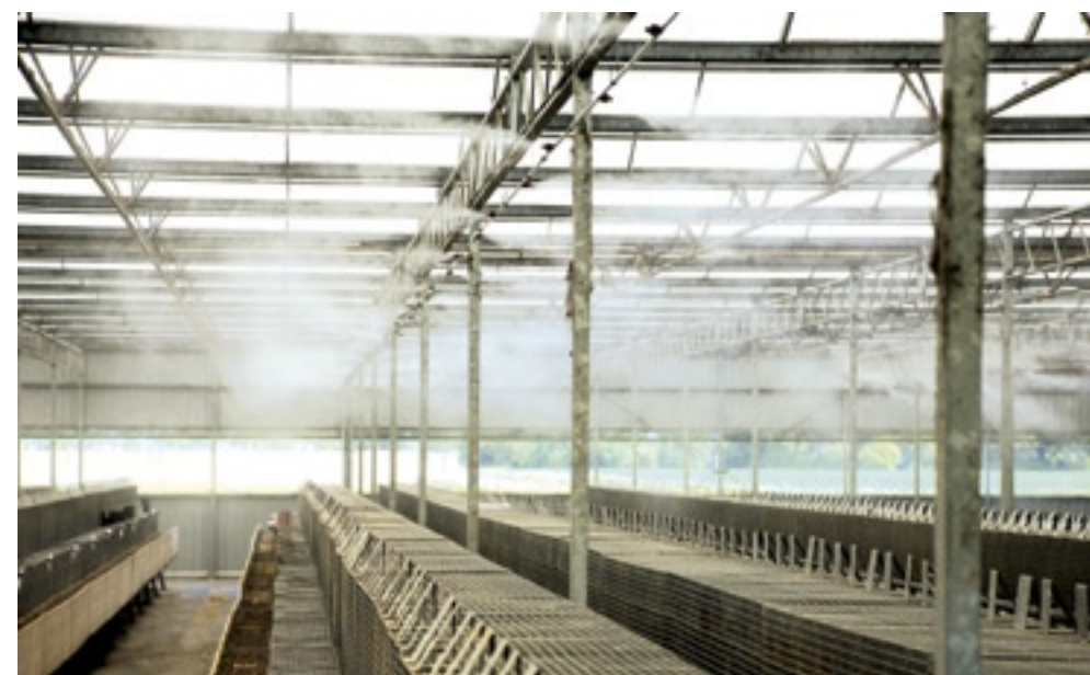
Een paar seconden is er een nevelmist te zien als er onder hoge druk water wordt verneveld in de geiten- en nertsenstallen van Van Voorthuijsen.
