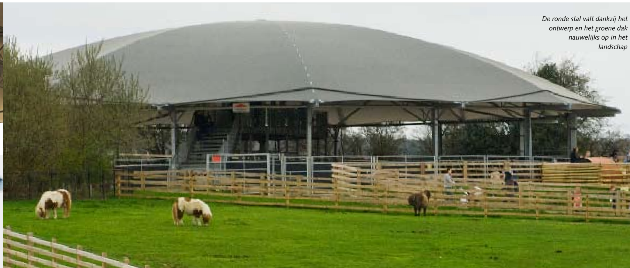
Pvc-gecoat polyesterdoek over stalen frame
