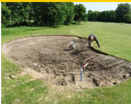
Het vorm geven van de ondergrond.
