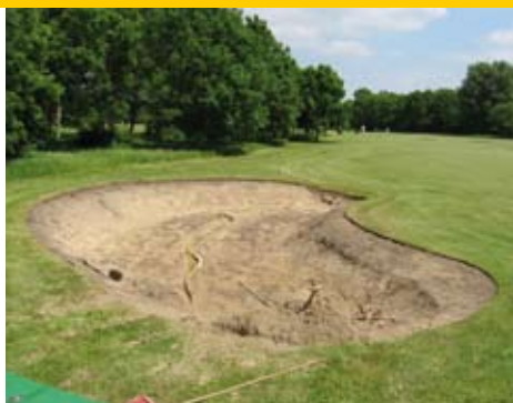
Zo ziet het er uit na het verwijderen van het zand.
