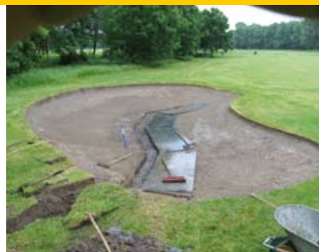
De ondergrond is klaar en de drainage geul wordt gegraven
