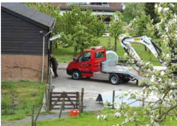
◀ Onder aan de Diefdijk plaatsen we de machine in een loods. Net als in de praktijk even uit het zicht zetten om te kijken of de machine is uitgerust met een track-and-tracesysteem.
