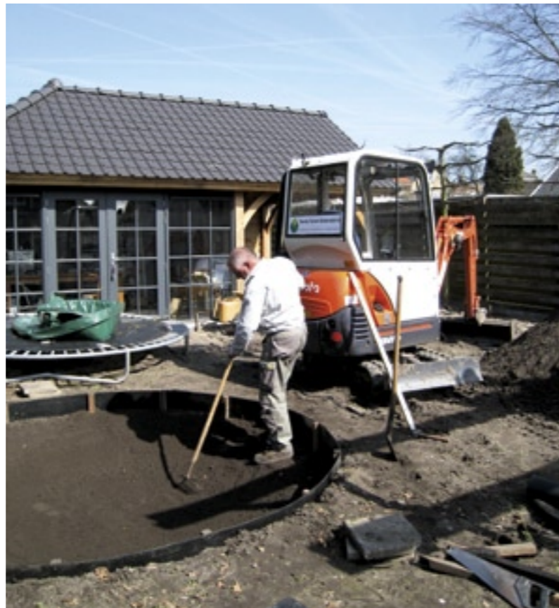
Voordat we het doek in de kuil onder de trampoline kunnen leggen, wordt de ondergrond aangeharkt.
