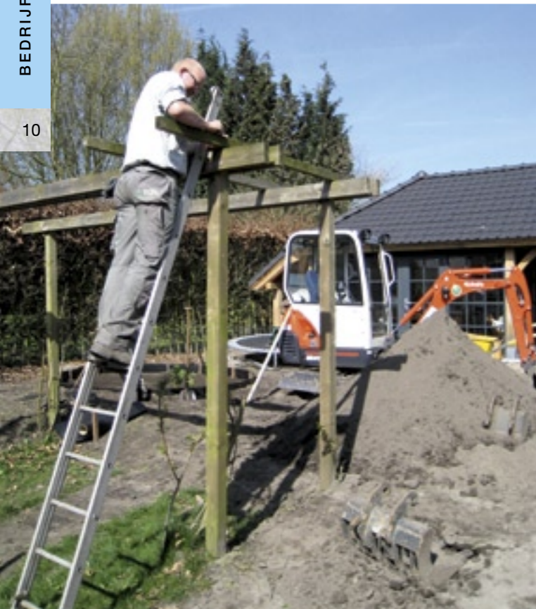
De pergola wordt behoedzaam uit elkaar gehaald, zodat de opdrachtgever het hout nog voor andere doeleinden kan gebruiken.
