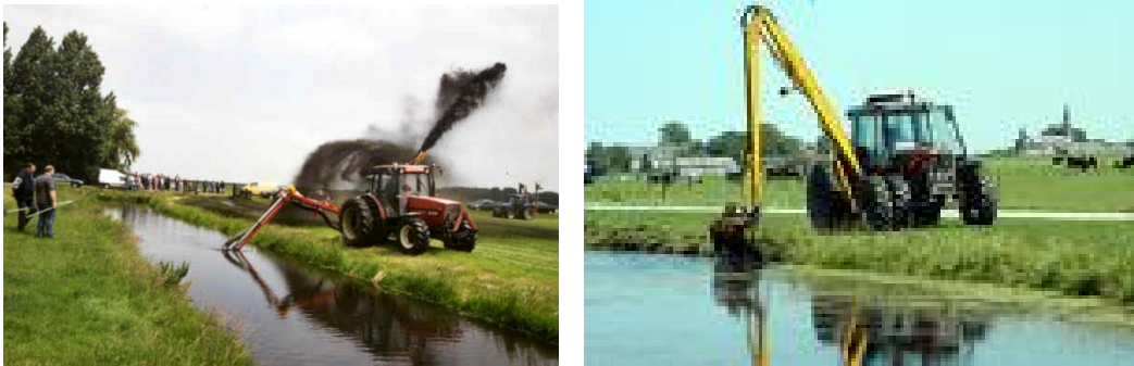
Figuur 1. Bagger verwijdering met een baggerspuit (links) of met een baggerschep (rechts). Afbeeldingen afkomstig van www.waterbodem.nl en www.zuidholland.nl .
