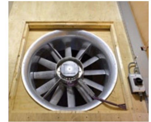
▲ Een ventilator met EC-motor is eenvoudig aan te sluiten en toerengeregeld.
