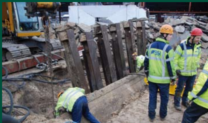
De naar voren getrokken rijplaat die als verankering dient voor de palen, wordt weer teruggeplaatst zodat er een nieuwe sleep poging gedaan kan worden.
