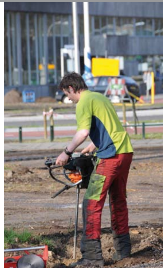
Aanbrengen van ondergrondse verankering en het resultaat
