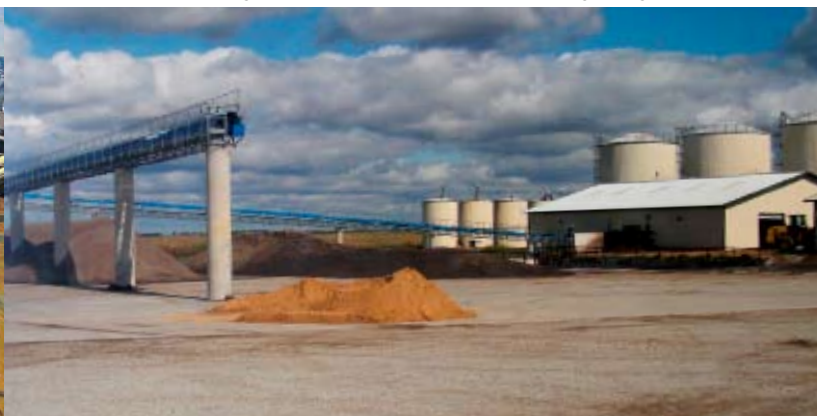
Zand wordt van de mest gescheiden, waarna het naar de vergister gaat
