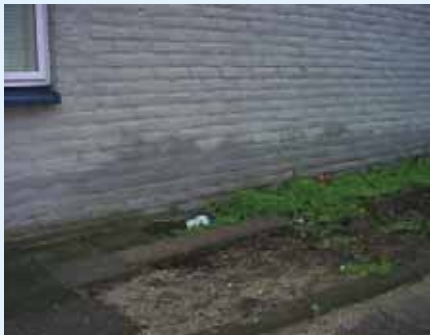
Optrekkend vocht door een te hoge grondwaterstand.
