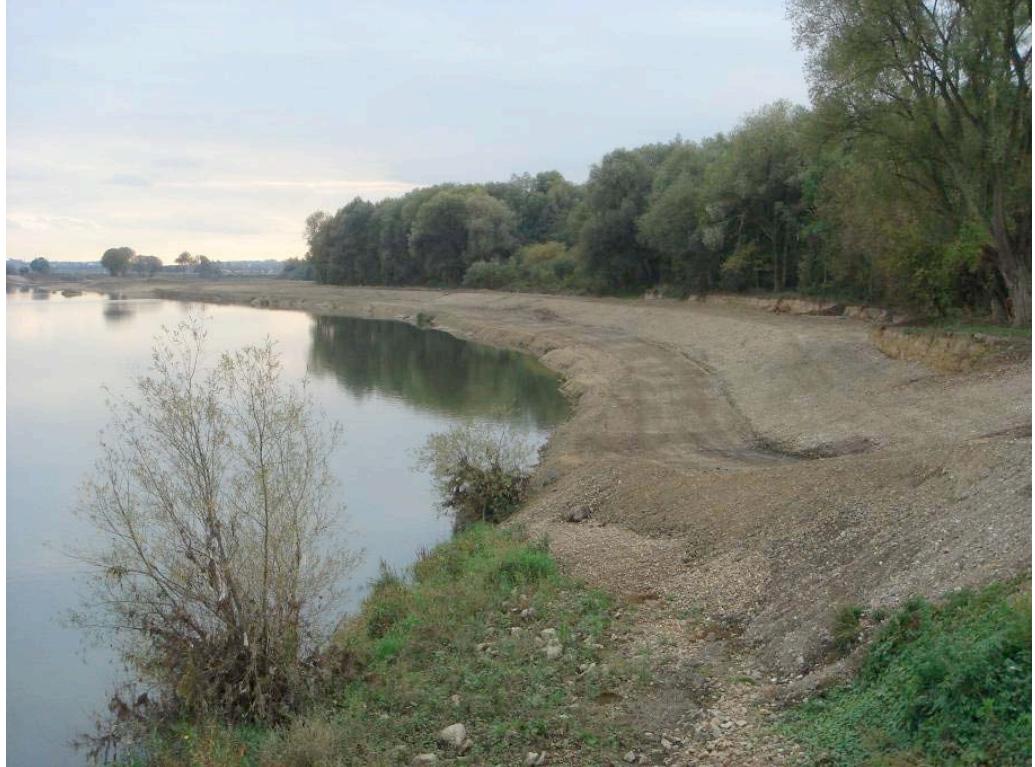
Figuur 4.1: Stroomgeulverbreding langs de Grensmaas bij Hochterbampd (september 2009) (foto: M. de la Haye).
