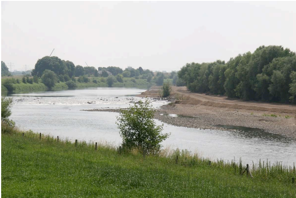
Figuur 2.20: Aan de Grensmaas wordt hard gewerkt. Hier een blik op de Vlaamse oeveraanpassingen in 2009 ter hoogte van Herbricht (foto: H. Gielen, nv De Scheepvaart). In het zomerbed is dwars op de stroomrichting een drempel te zien (nr. 9).
