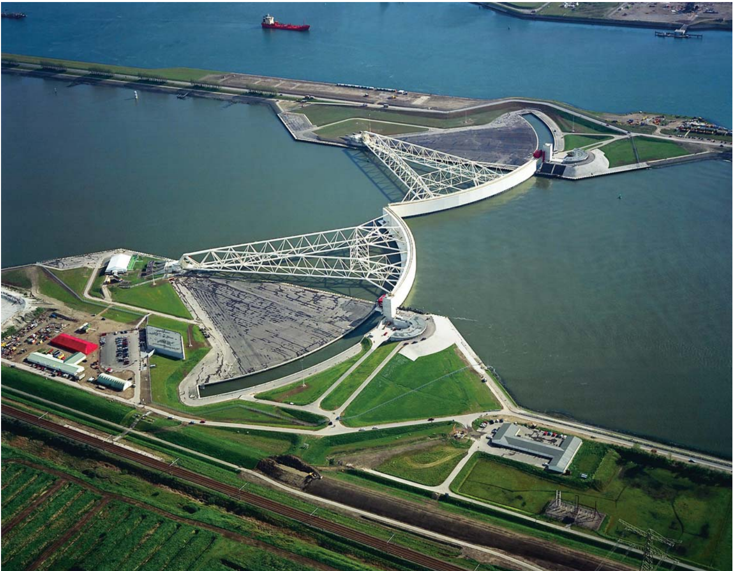
Maeslantkering. Het sluitstuk van de Deltawerken, die vooral staan voor 'veiligheid'. Bron: Rijkswaterstaat.
