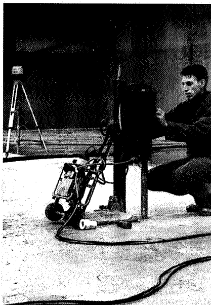
Op elke 10 m 2 wordt een gat in de vloer geboord met een diameter van 5 cm
