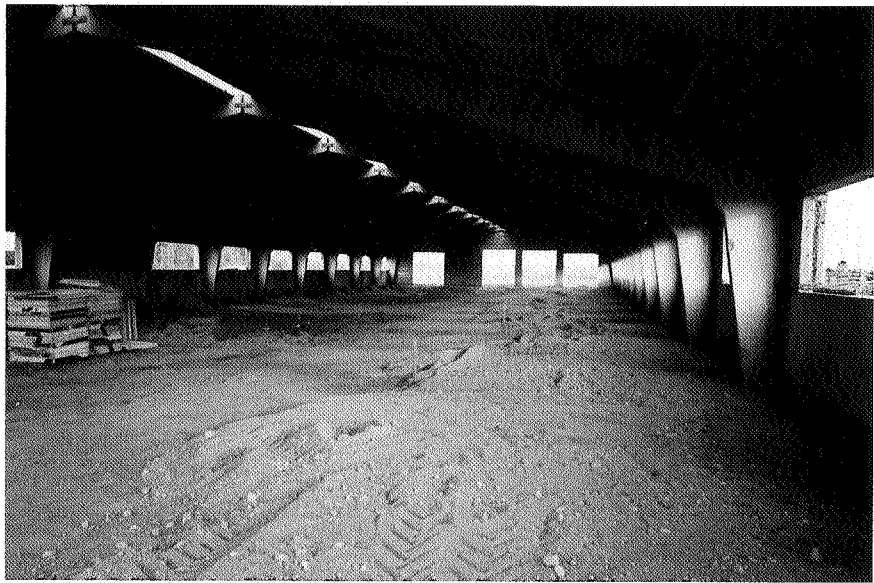
Pas nadat het gebouw is geplaatst wordt de prefab betonstal van binnen ingericht
