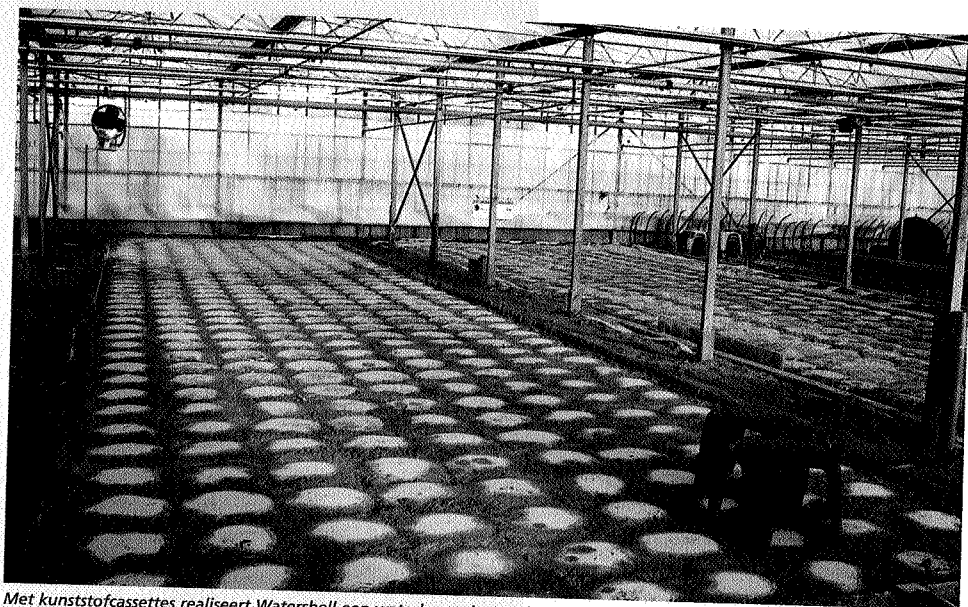
Met kunststofcassettes realiseert Watershell een waterbeweging onder de teeltvoer
