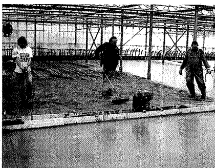
De betonspecie wordt verdicht met een dubbele trilbalk
