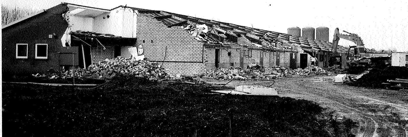
De sloop van een varkensstal
