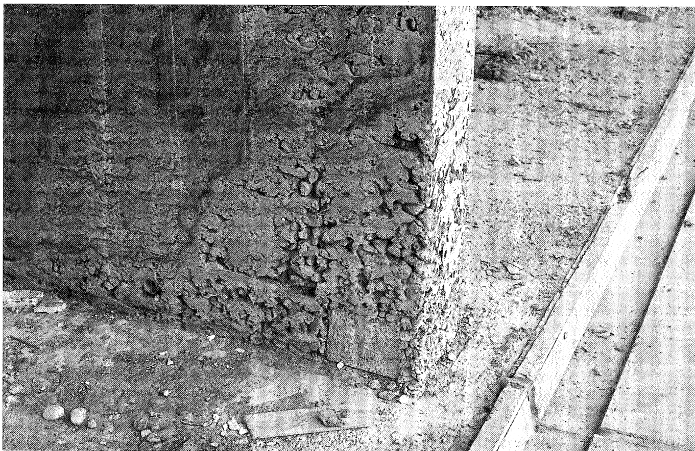
Grindnesten kunnen worden voorkomen door op alle plaatsen voldoende te verdichten
