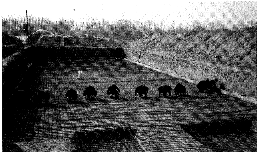
Wapening wordt met de hand gevlochten
