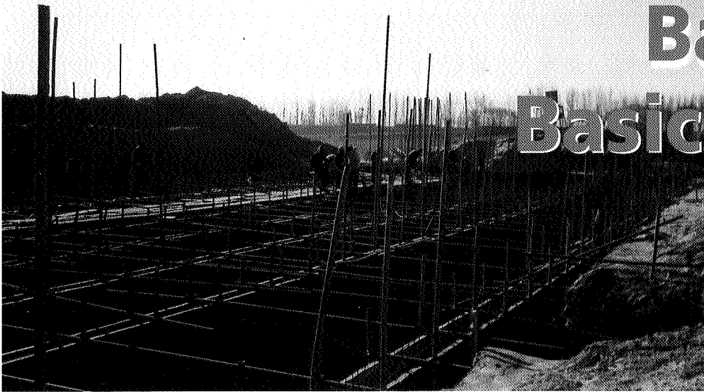
In China is nog geen ervaring met opslag van drijfmest onder de stallen
