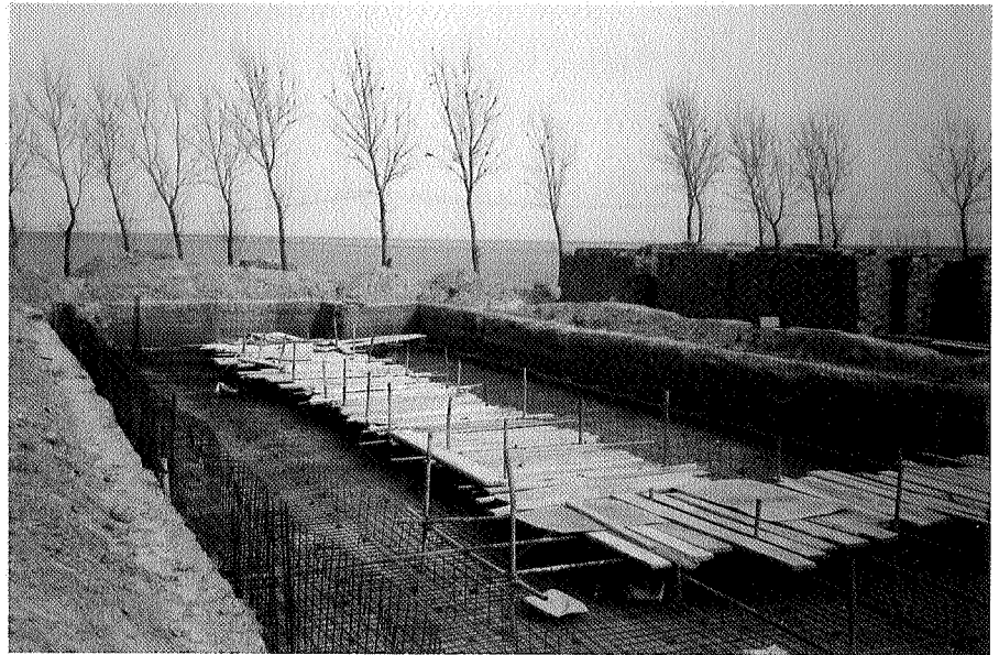
Om het betonstorten mogelijk te maken, wordt allereerst een werkplatform aangelegd
