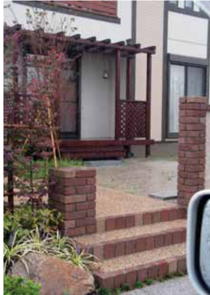
Vijf treden tussen het straat- en vloerpeil in een woonwijk in Saga in het zuidwesten van Japan (foto: Frans van de Ven).
