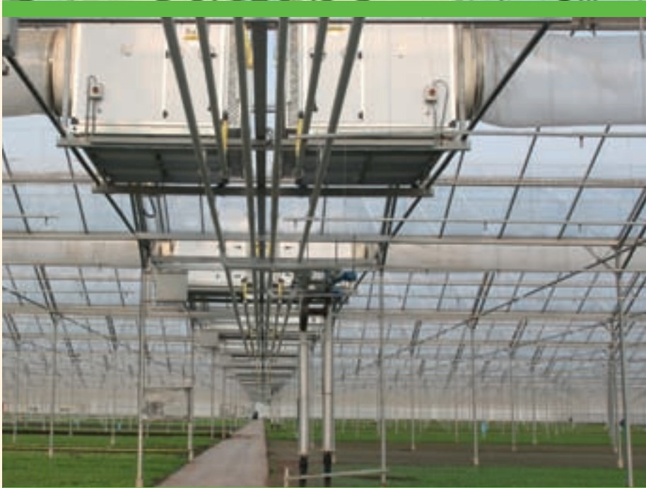
De luchtbehandelingskasten en luchtslangen in de open breedkapkas zitten in de nok, één per tralie.
