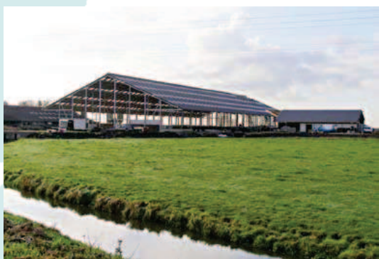
De nieuwe stal in aanbouw, met het melklokaal, voorzien van een 2x26-swing-over melkstal.
