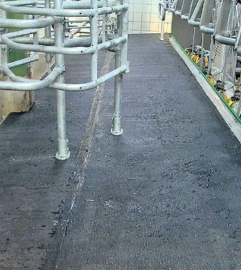
▲ Door het rubber onder de staanders van de stal te monteren, voorkom je dat je in de mat moet snijden. Langs de naden zou vuil onder de mat kunnen komen.
