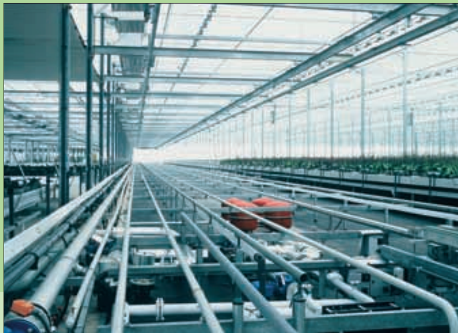
Pilotproject kaskoeling en -verwarming met ondergrondse opslag en warmtepompen.
