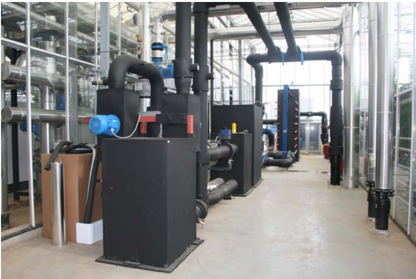
Warmtewisselaars tussen kas en aquifer
