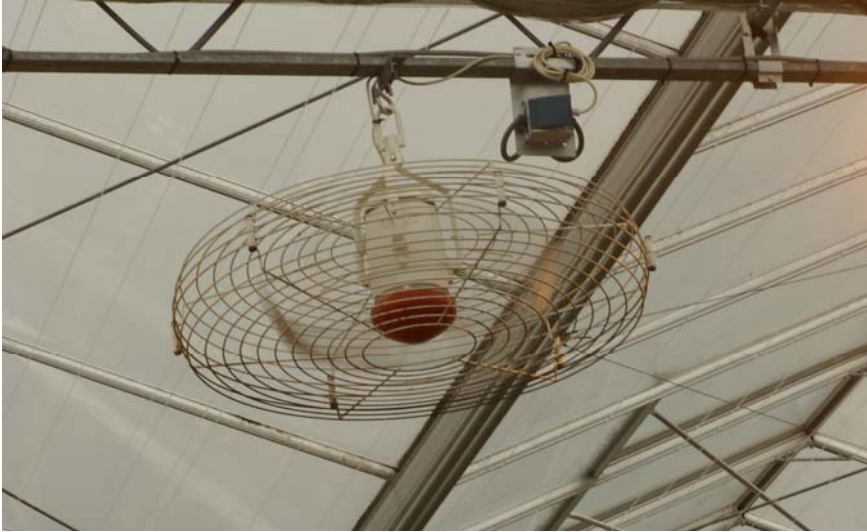
Nivolator verplaatst lucht in horizontale en verticale richting
