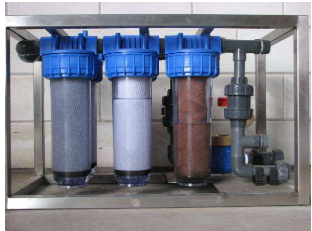
Condenswaterfilter met grof filterkaars (bruin) en actiefkool kaarsen
