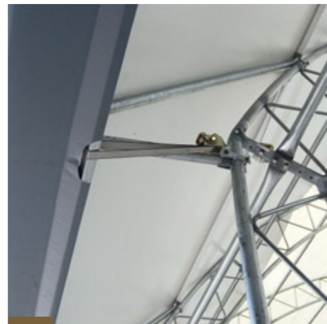
2,5 ton Op de folie komt zo’n 2,5 ton spankracht te staan. Foto: Wilma Wolters
