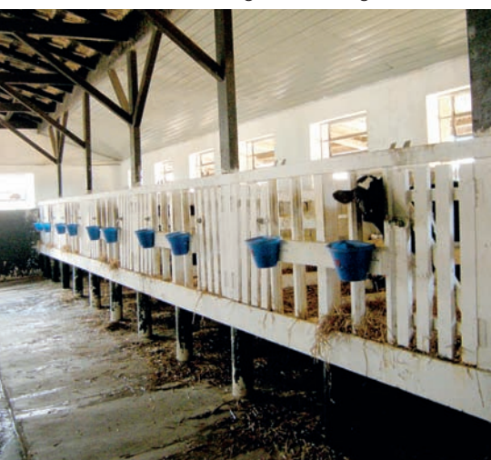
Kalverhuisvesting is eenvoudig
