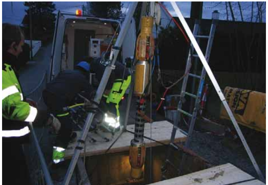
Inbrengen apparatuur in het mangat ...
