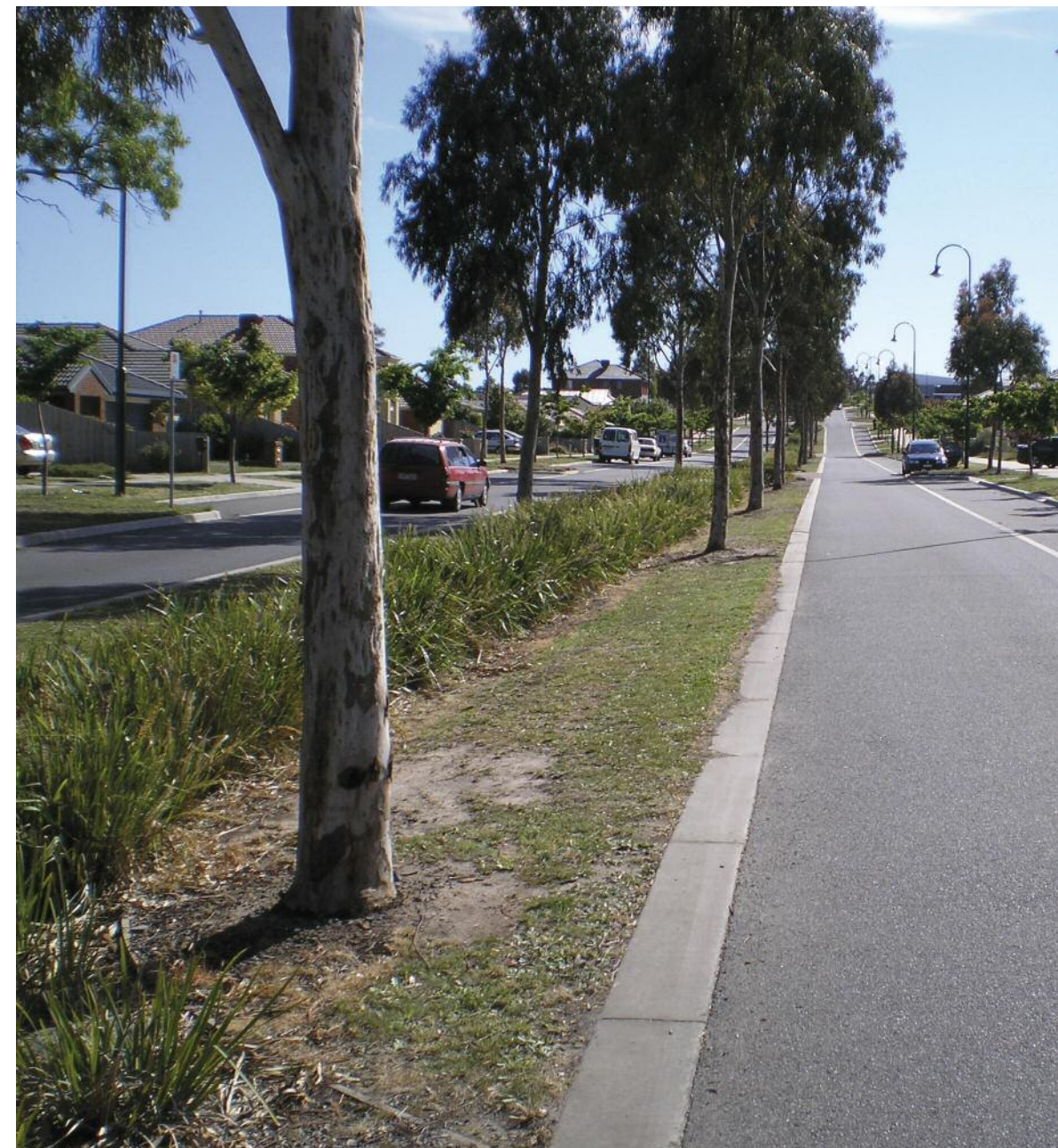
Figuur 11.5 Natuurlijke waterafvoer via de middenberm, Australië
