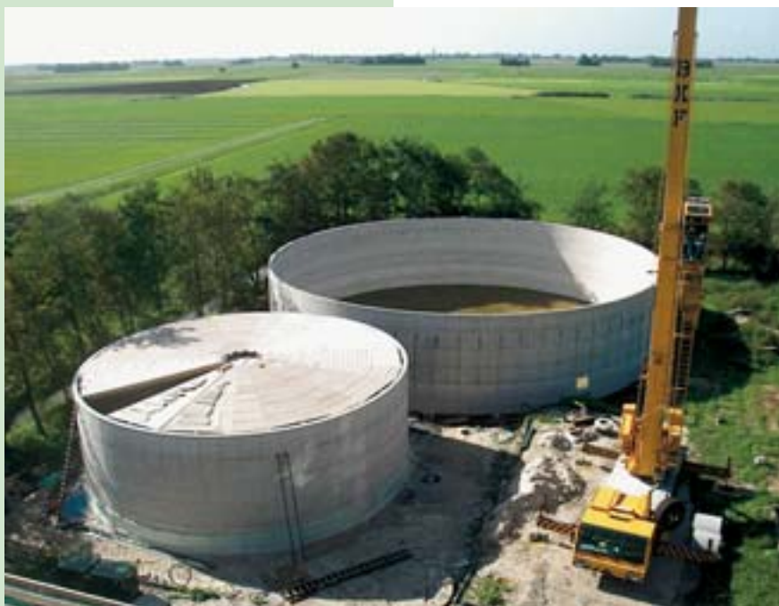
De bouw van betonnen mestvergistingsinstallaties
