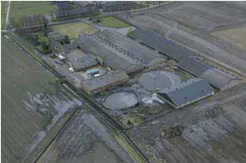
Een bassin met 2000 kuub mest in Rijkevoort (NBr) klapte in maart 2005 uiteen door verroeste staalkabels. De vloedgolf van mest reikte 60 meter ver en via een waterloop stroomde de mest naar de Maas Foto: Regionaal milieuteam Brabant-Noord
