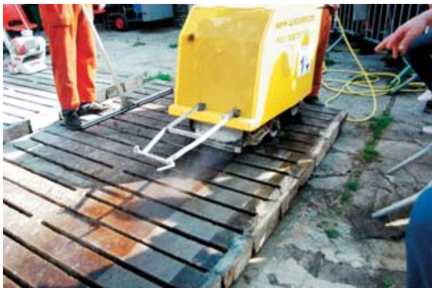
Met de diamantslijpmachine wordt dwars over de roostervloeren gewerkt zodat de afvoer van urine en mest naar de mestsluven mogelijk is
